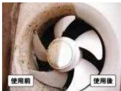
換気扇の油汚れ
