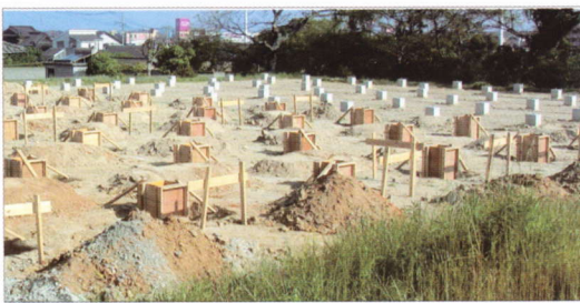
コンクリートにアンカーボルトを埋める
